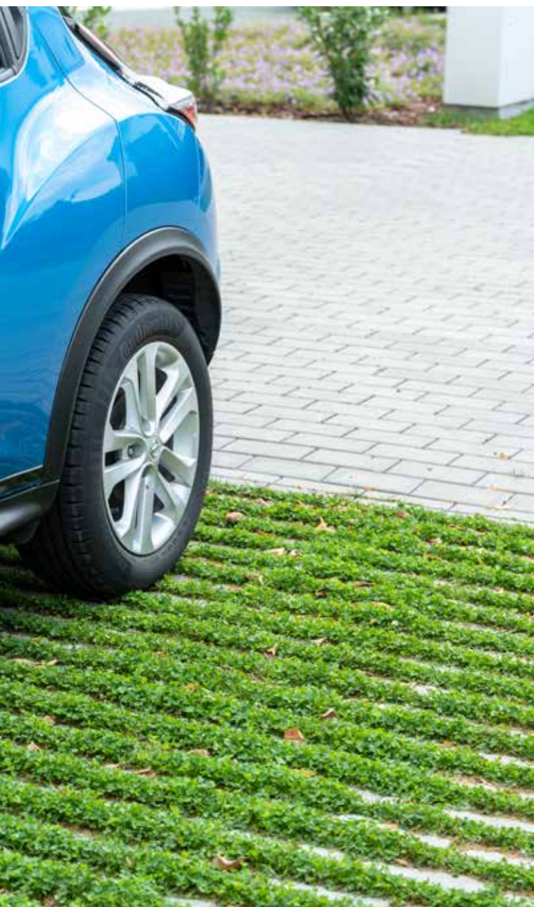
Parkeerplaats met Grasslines Small, met een kruidenmengeling als voegvulling
